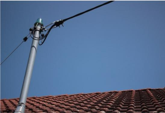
Dachständerleitung mit verdrehtem Kabel: keine Störungen bei korrekter Hausinstallation (von uns nachgeprüft)
