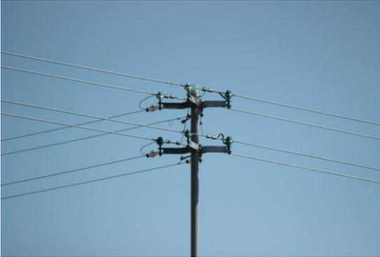
Dachständerleitung Einzelkabel: Störungen zu erwarten (von uns nachgeprüft)
