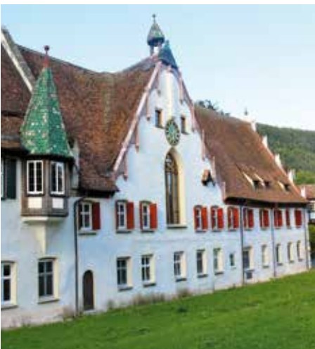
↑ Kloster Blaubeuren: Im 15. Jahrhundert wurde es nach einem Brand komplett neu errichtet.
