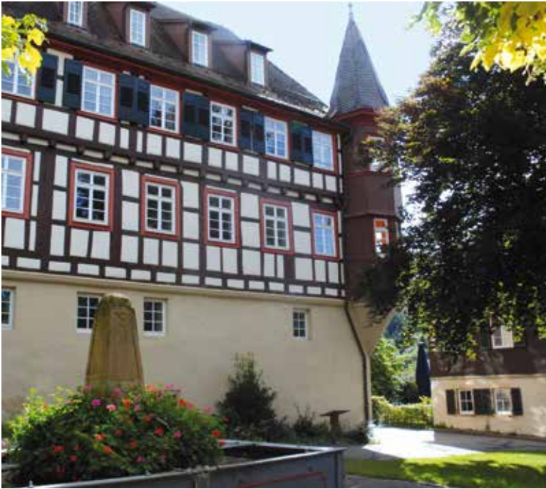
↑ Nachreformatorisch: der Klosterhof mit der alten Oberamtei.
